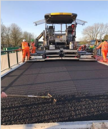
Aanbrengen Lynpave
