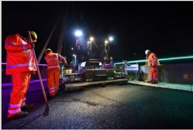
Aanbrengen van het MElt® in de praktijk
